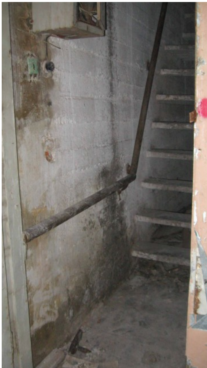
Историческое здание московской школы №201 имени Зои и Александра Космодемьянских. Лестница, ведущая на крышу. 2011 год.
