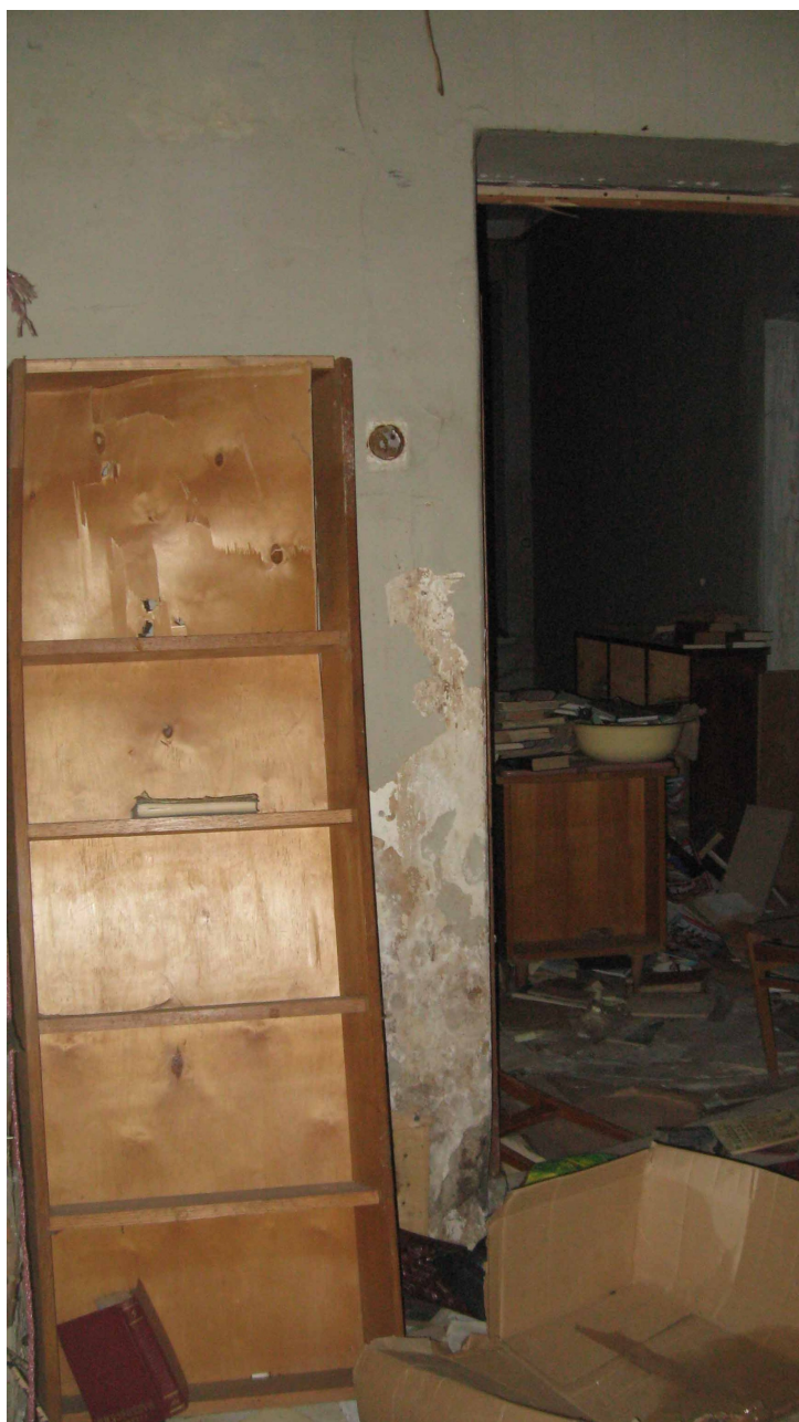
Историческое здание московской школы №201 имени Зои и Александра Космодемьянских. Жилое помещение на первом этаже школы. 2011 год.
