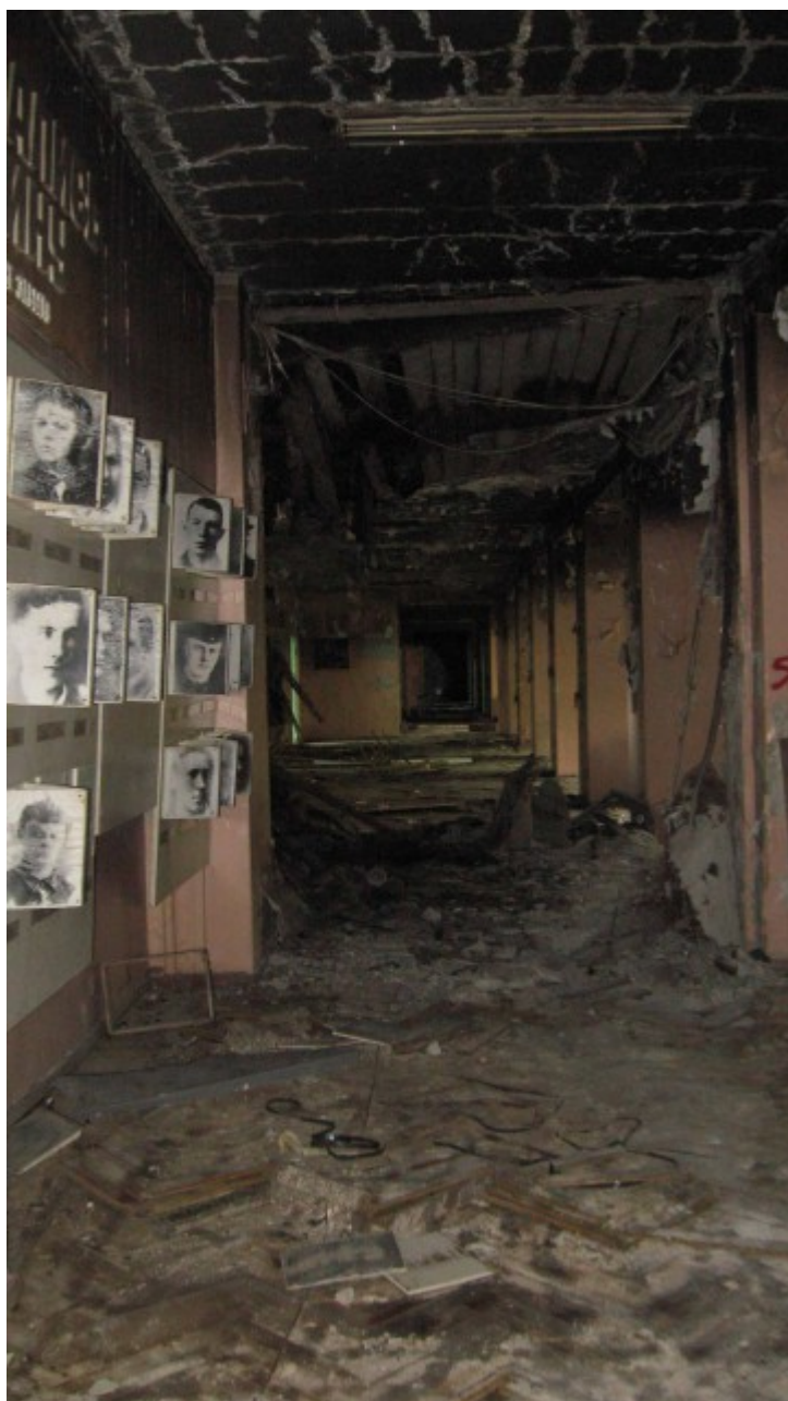
Историческое здание московской школы №201 имени Зои и Александра Космодемьянских. Коридор второго этажа. 2011 год.
